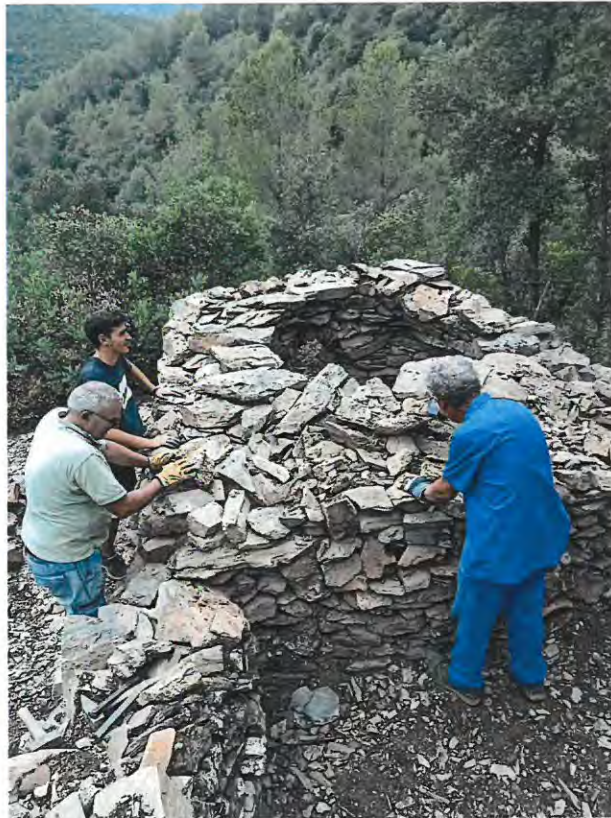
Imatge de les tasques de restauració de la barraca a la Vinya de Cireres
